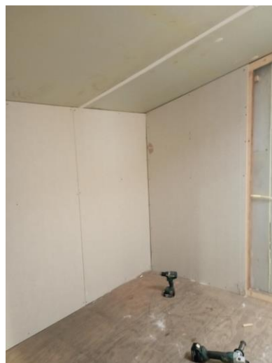
In februari 2024 zijn de elektra leidingen aangelegd in de wanden. Er zijn 5 dubbele dozen (blauw) voor de te plaatsen vaste rand gearde wandcontactdozen voorzien. Ook zijn deze maand de gipsplaten wanden aangebracht.
