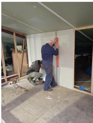
In februari 2024 zijn de elektra leidingen aangelegd in de wanden. Er zijn 5 dubbele dozen (blauw) voor de te plaatsen vaste rand gearde wandcontactdozen voorzien. Ook zijn deze maand de gipsplaten wanden aangebracht.
