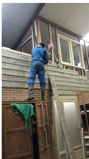
De gevel is vanaf half februari tot eind februari betimmerd met rabatdelen. In de gevel zijn een (buitendeur) en een venster geplaatst. Ook is er lichtinval vanaf boven. In de linkerwand van de shack is een (binnen)deur naar de zolder met nooduitgang geplaatst.
