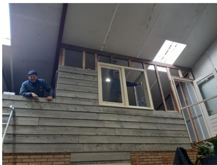
De gevel is vanaf half februari tot eind februari betimmerd met rabatdelen. In de gevel zijn een (buitendeur) en een venster geplaatst. Ook is er lichtinval vanaf boven. In de linkerwand van de shack is een (binnen)deur naar de zolder met nooduitgang geplaatst.
